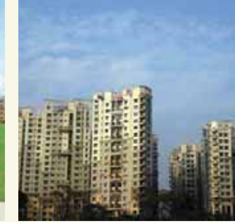
SILVER SPRING EM Bypass, 502 units
